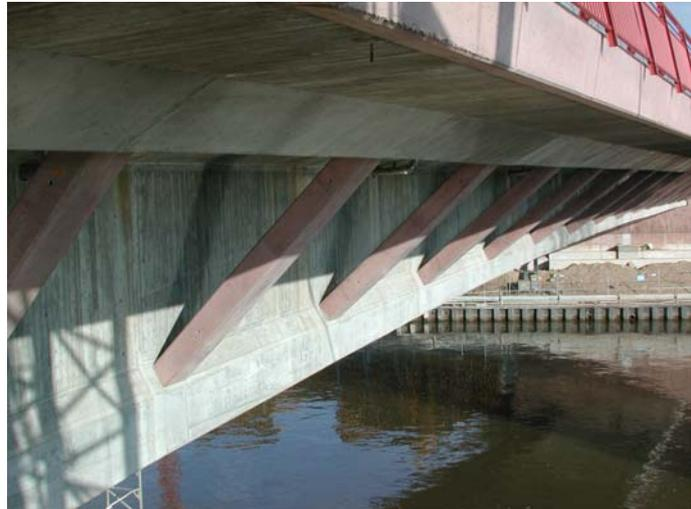
Zusätzlich erhält die Fahrbahnplatte eine Quervorspannung mit internen verbundlosen Spanngliedern aus Monolitzen. Diese sind genauso wie die externen Längsspannglieder jederzeit austauschbar.
