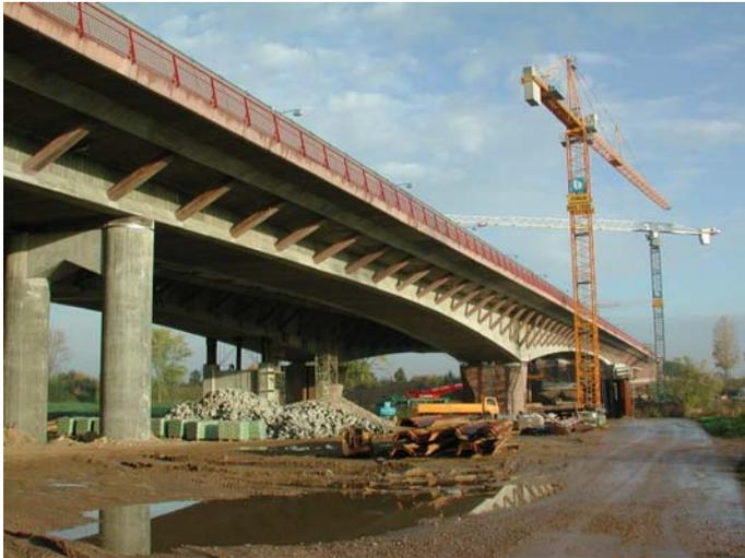
Es wird für jede Fahrbahnrichtung getrennt voneinander eine eigene Brücke hergestellt, wobei die Brücke in Fahrtrichtung Norden bereits fertiggestellt ist und für den Verkehr freigegeben wurde.
