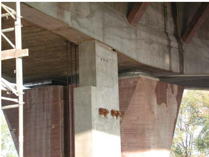
Die so genannte Grundetappe, mit der ein Freivorbau beginnt, wird neben der Auflagerung auf den tatsächlichen Stützenpfeilern durch zusätzliche Hilfsstützen stabilisiert, die im Zuge des Baufortschritts wieder entfernt werden.
