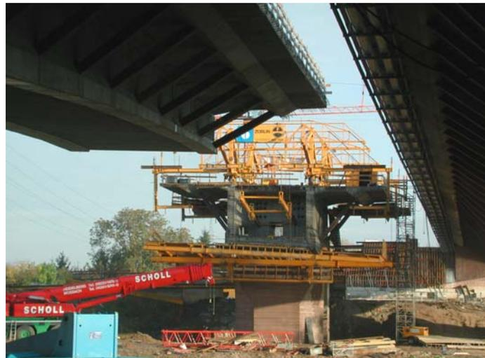
Die noch im Bau befindliche Brücke wird in der so genannten Mischbauweise hergestellt, bei welcher sowohl Spannglieder mit Verbund als auch verbundlose externe Spannglieder zum Einsatz kommen. Die Herstellung des Überbaus erfolgt taktweise, wobei jeder Takt eine Länge von ungefähr 5 m und eine Bauzeit von 1 Woche umfasst.
