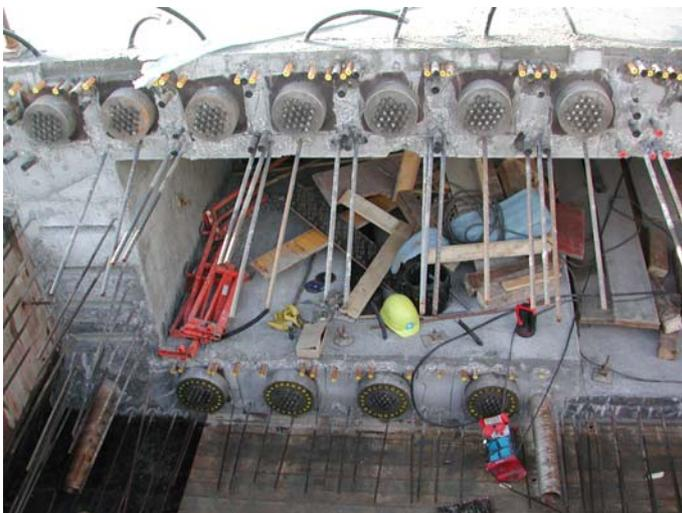
Alternativ dazu können die Spannglieder entweder durch den Anschluss an Koppelstellen oder durch Weiterführung der Hüllrohre in den oder die nächsten Bauabschnitte fortgesetzt werden (Foto: Koppelanker und überstehende Hüllrohre in unterer Platte).
