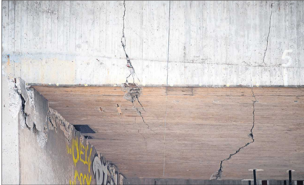
Wissenschaftler forschen seit Jahren an nachhaltigen Methoden, wie sich kleinere Risse in Beton wieder schließen lassen. Selbstheilender Bakterien-Beton könnte die Lösung sein.
