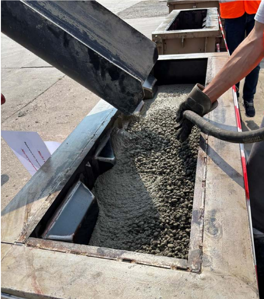
Abbildung 13: Einfüllen der InnoBeton-Mischung in eine Schalung (M. Denu)
