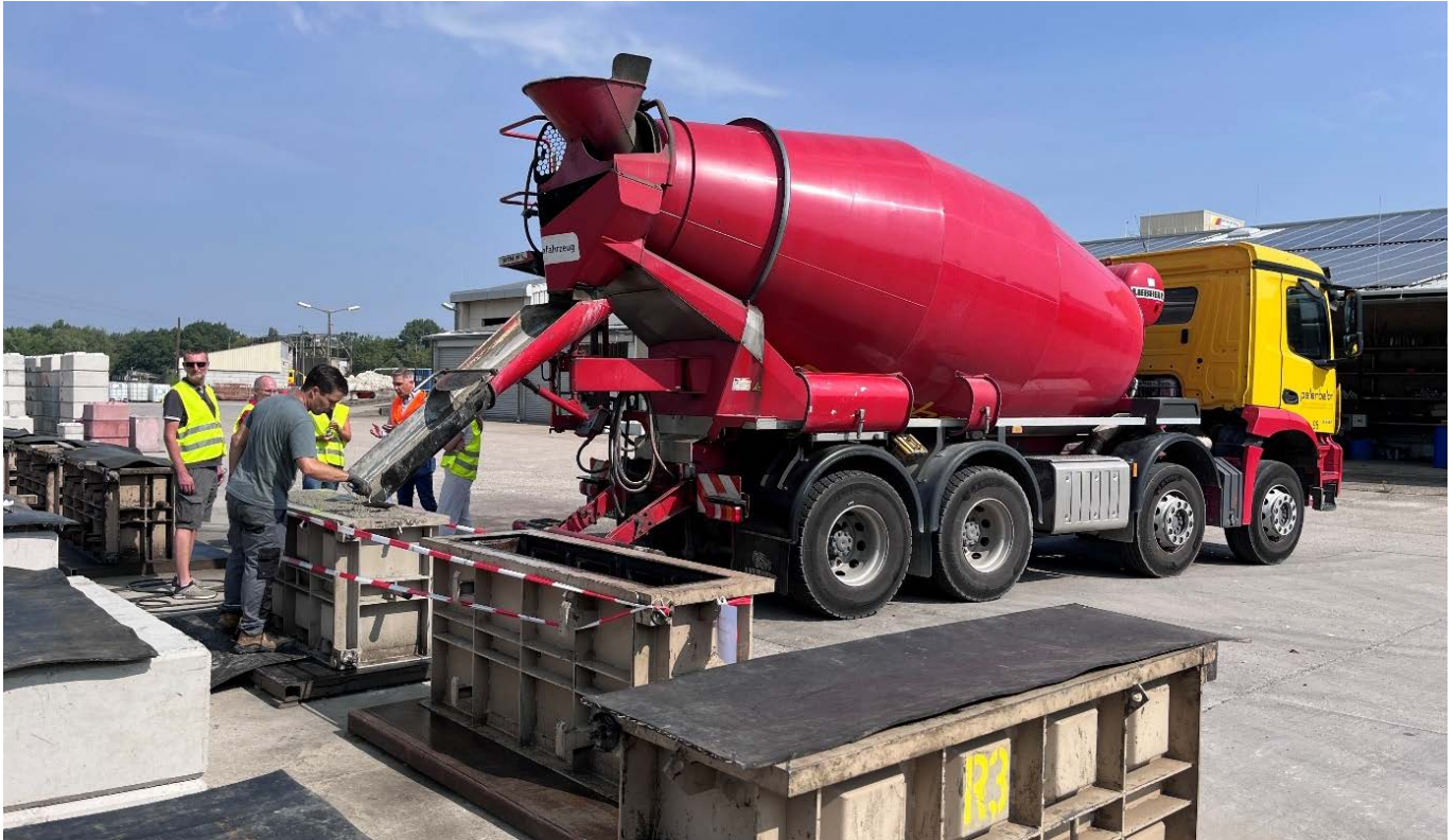
Abbildung 12: Herstellung des InnoBeton-Demonstrators (M. Denu)
