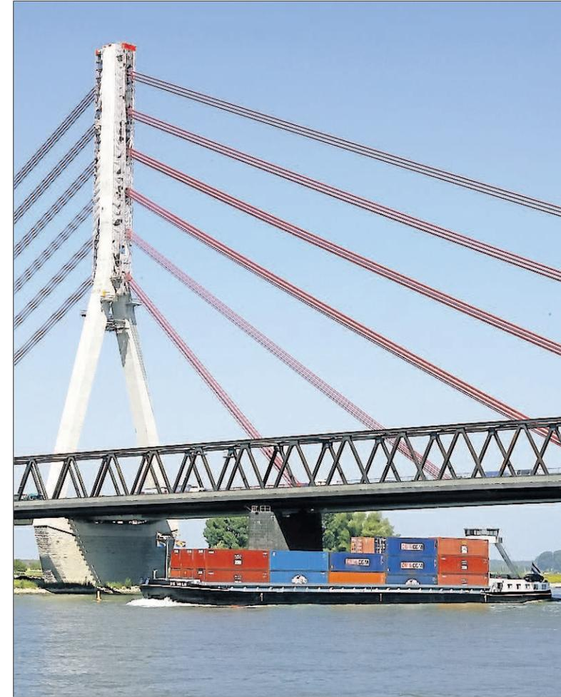
Die neue und 770 Meter lange Rheinbrücke bei Wesel ist eine typische Schrägseilbrücke. Der Pylon ist 130 Meter hoch.
