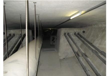
*Im hohlen Inneren der Betonbrücken verlaufen die zu untersuchenden Spannseile. (Foto: S. Siegel/KIT)*
