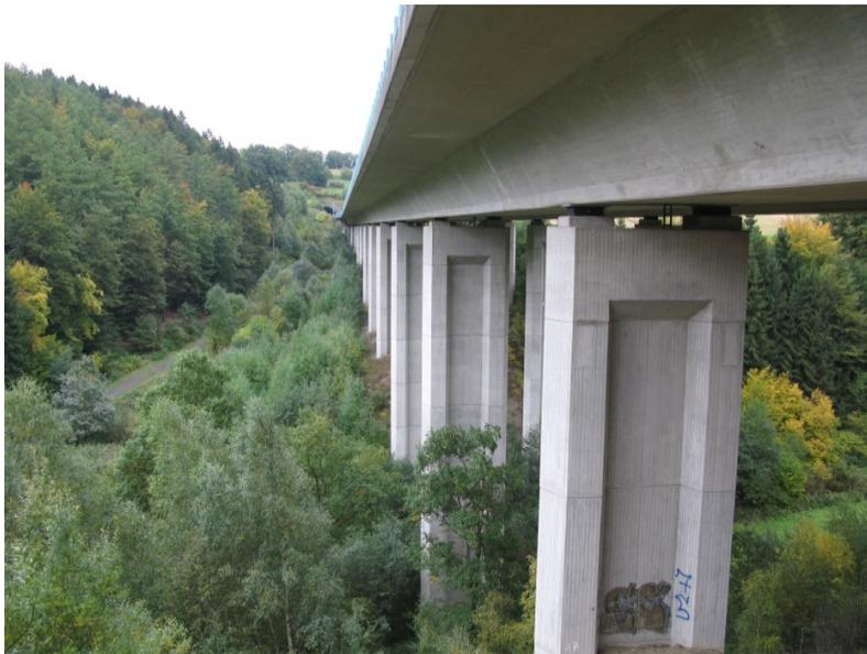
Extern vorgespannte Betonbrücken sind in Deutschland weit verbreitet. (Foto: S. Siegel/KIT)
