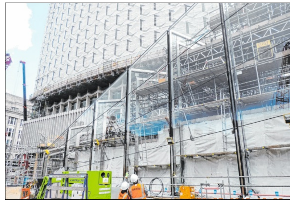
NEUES GLASGESICHT: Bei der Eingangshalle der Londoner U-Bahn-Station „Tottenham Court Road“ ist das Glas nicht nur Fassade, sondern hat auch tragende Funktion.
